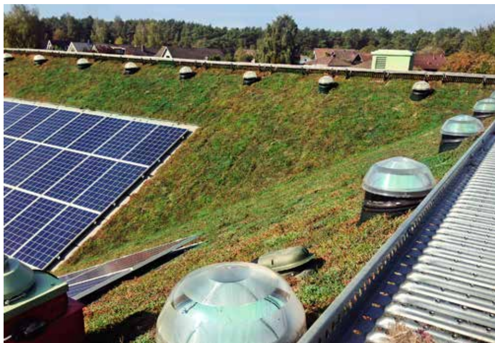
I Vadstena kommun har man försett en förskola med solceller och skapat dagsljus med hjälp av Solatube på ett så kallat suckulenttak. FOTO: VADSTENA KOMMUN
