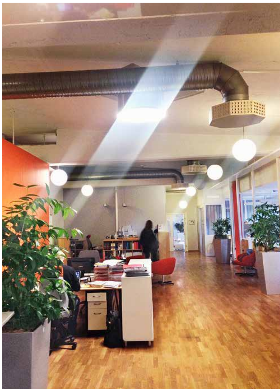
Solatube har ett U-värde ner till 0,5 W/(m 2 K) och lämpar sig väldigt bra för exempelvis passivhus.
