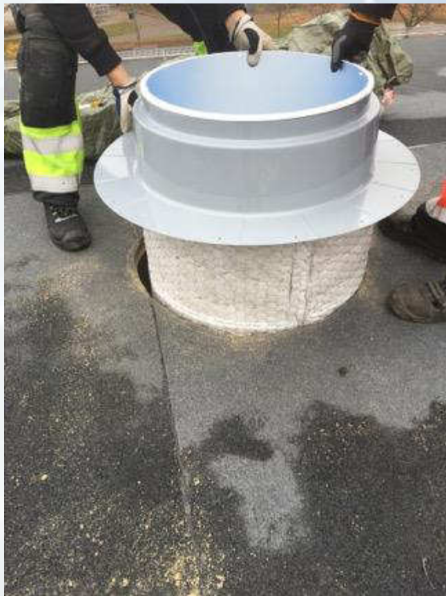
Huven och röret med isolering sänks ner genom öppningen.
